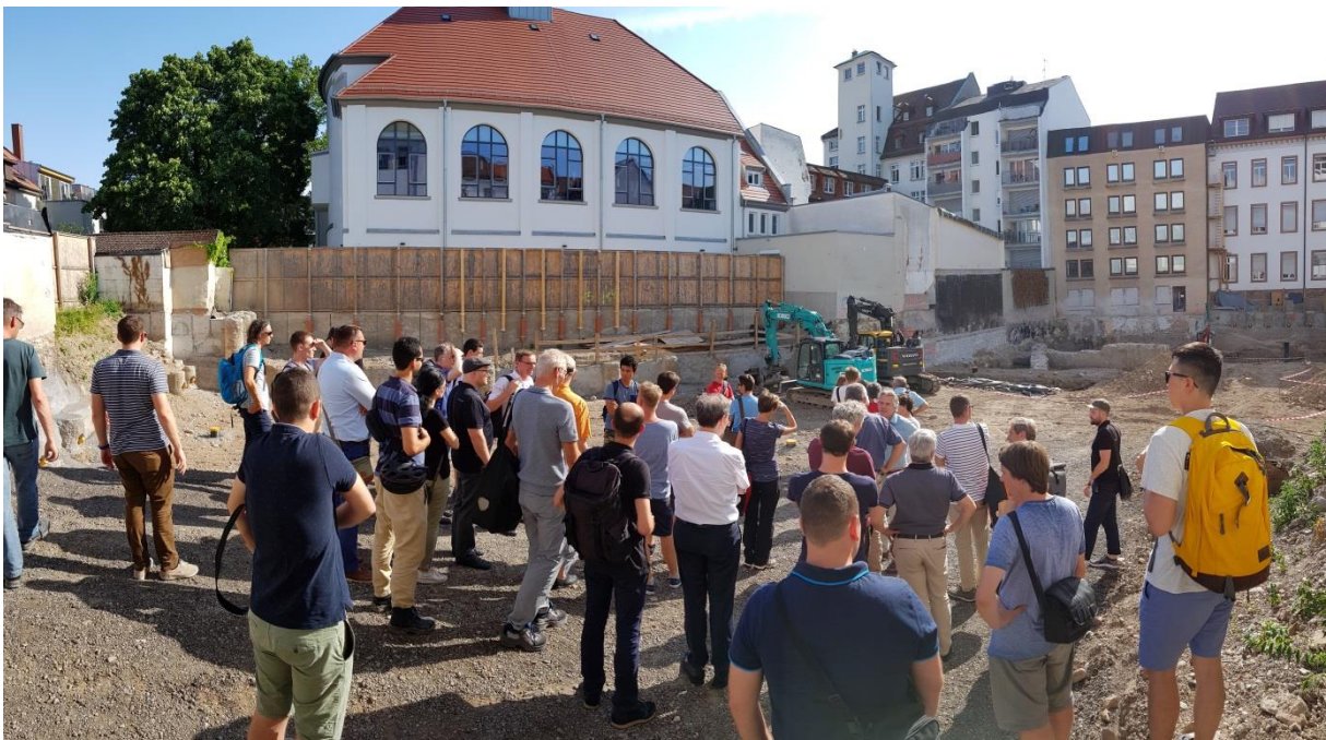
Bild: Die Teilnehmer der BWK-Exkursion bei der Baustellenbesichtigung
