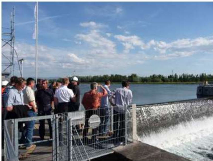
Ein Blick auf das erste Wehrfeld
