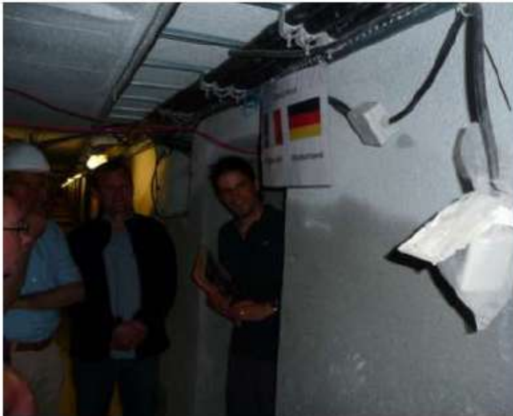
An der Staatsgrenze im An der Wartungstunnel
